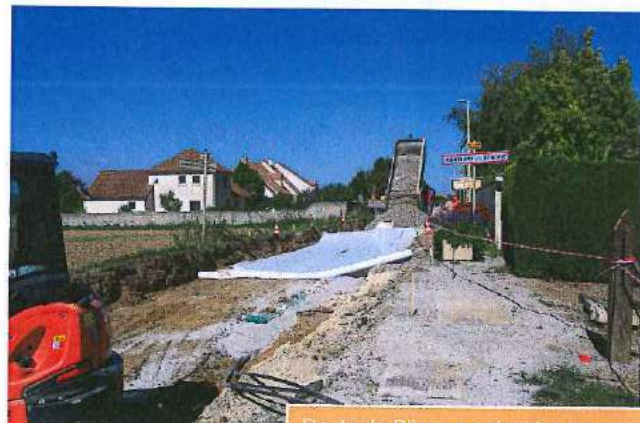
Route de Bligny pendant les travaux
