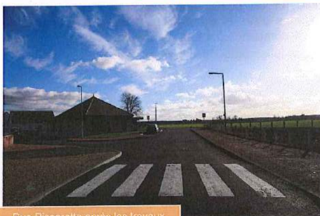
Rue Pisserotte après les travaux
