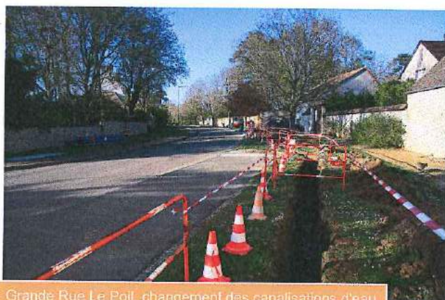
Grande Rue Le Poil, changement des canalisations d'eau
