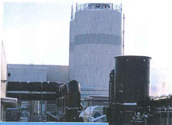
Usine de traitement des déchets Chagny
