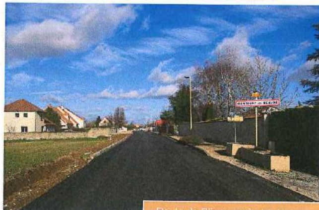
Route de Bligny après les travaux
