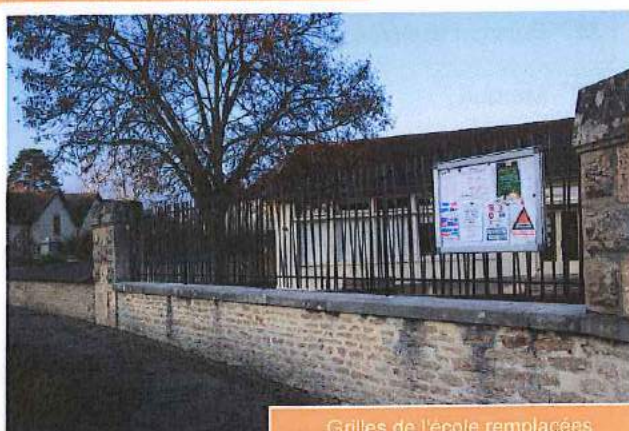
Grilles de l'école remplacées
