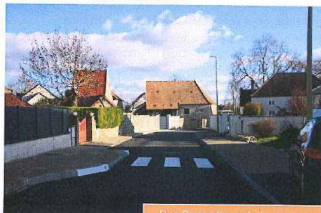
Rue Pisserotte après les travaux
