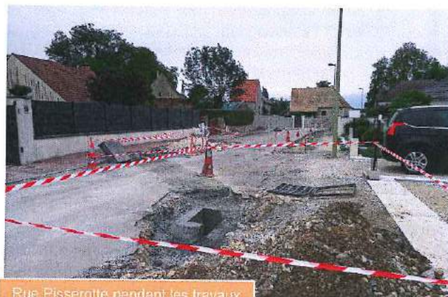
Rue Pisserotte pendant les travaux
